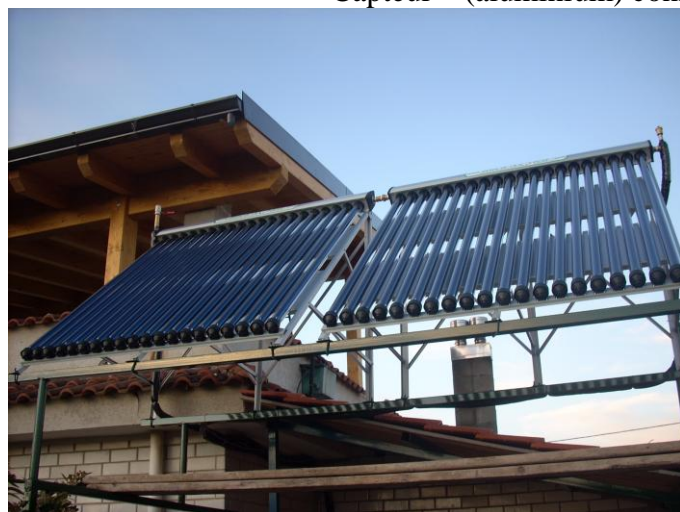
Capteur (aluminium) connecteurs laiton 1"
