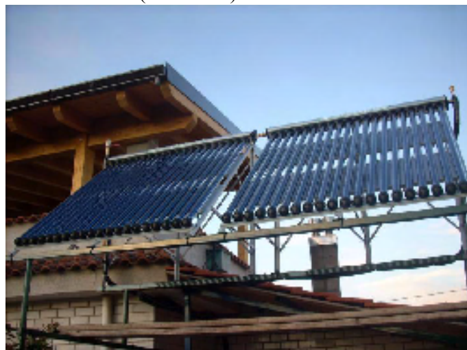
Manifold (alluminio) connettori ottone 1"
